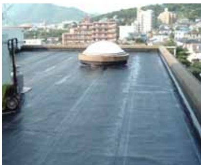
屋上の防水工事
