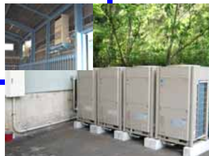
定温倉庫設備に改修
