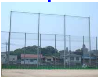
グラウンドの防球ネットの改修
