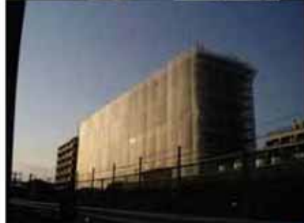
外壁吹き替え
