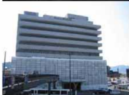
外壁補修工事
