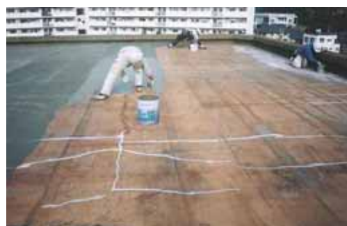
屋根防水改修工事
