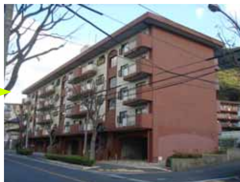
外壁改修工事
