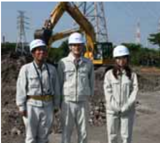
戸畑港運輸棟中原1号、2号倉庫新築工事
