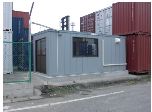
プレファブ事務所設置工事
