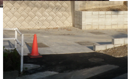
住宅用造成および浄化槽設置工事
