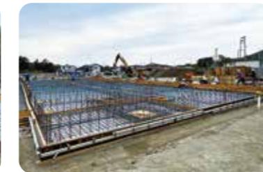
当現場は玄洋会様の新しい入所施設の工事です。1月後半より着工し、現在基礎工事が完了、3月後半より躯体工事を進めていきます。6月初旬に上棟予定、また同時期に内外装工事も始まります。クレーン作業や高所作業も多くなり、作業員数も増えたため、日々の安全計画の確認と安全管理を徹底し、各々の安全意識の高揚を図りながら、無事故無災害で進めています。
