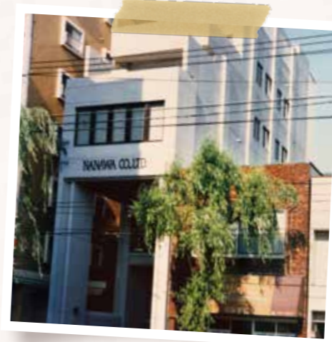
▲福岡支店配属後、初めての現場
